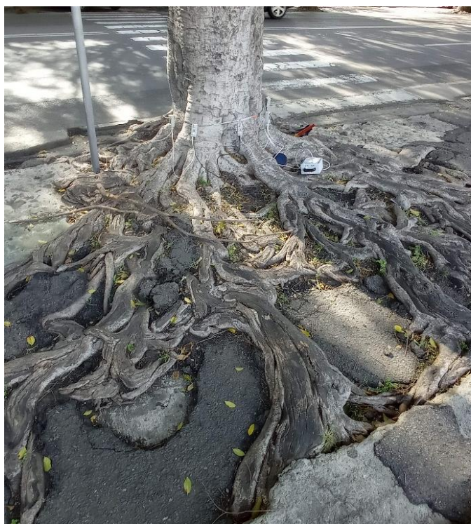
Foto n°2 – Radici affioranti gravi
