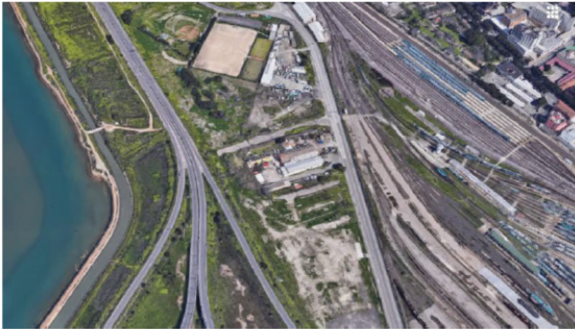
Ortofoto e viste aeree area d'intervento – Fonte Sardegna Fotoaeree
