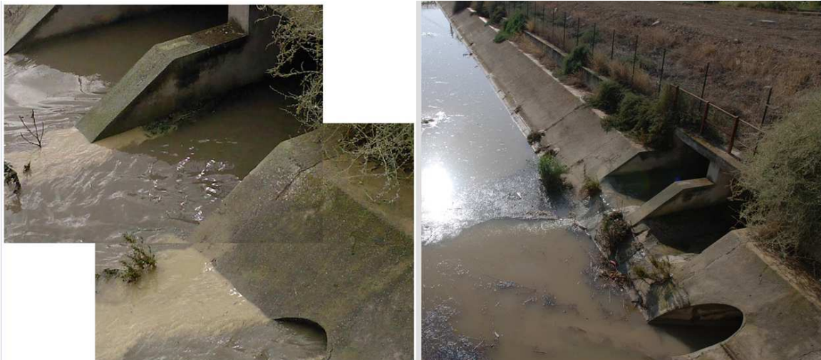
Figura 3.2 - Stato del livello su alcune luci di scarico nella parete di sponda destra del canale Terramaini durante l'evento del 2008 (a sinistra in condizioni di piena e a destra qualche ora dopo)
